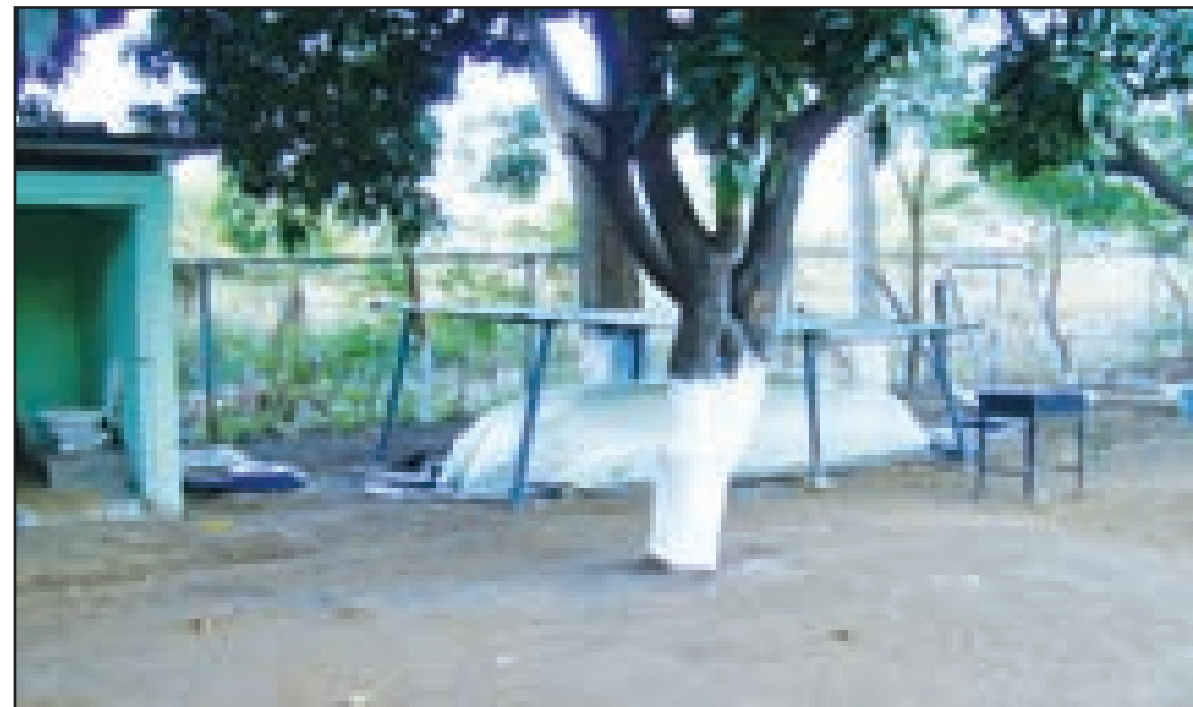
Biodigestor alimentado por excretas humanas en el CIPRES -Managua
