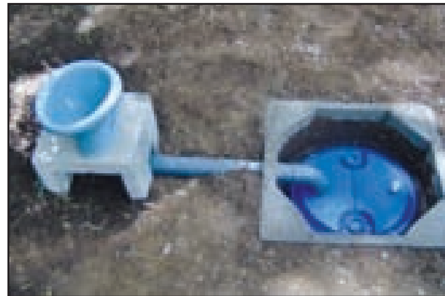
Conexión correcta del tubo de acarreo y los soportes en las esquinas del brocal
