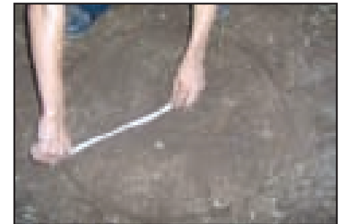
Midiendo área para excavación de fosa
